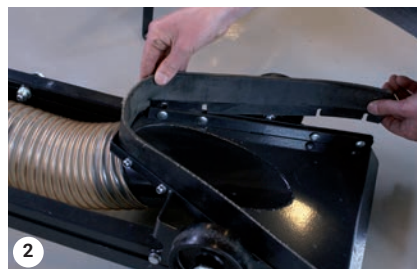
Монтиране нов гумен профил
